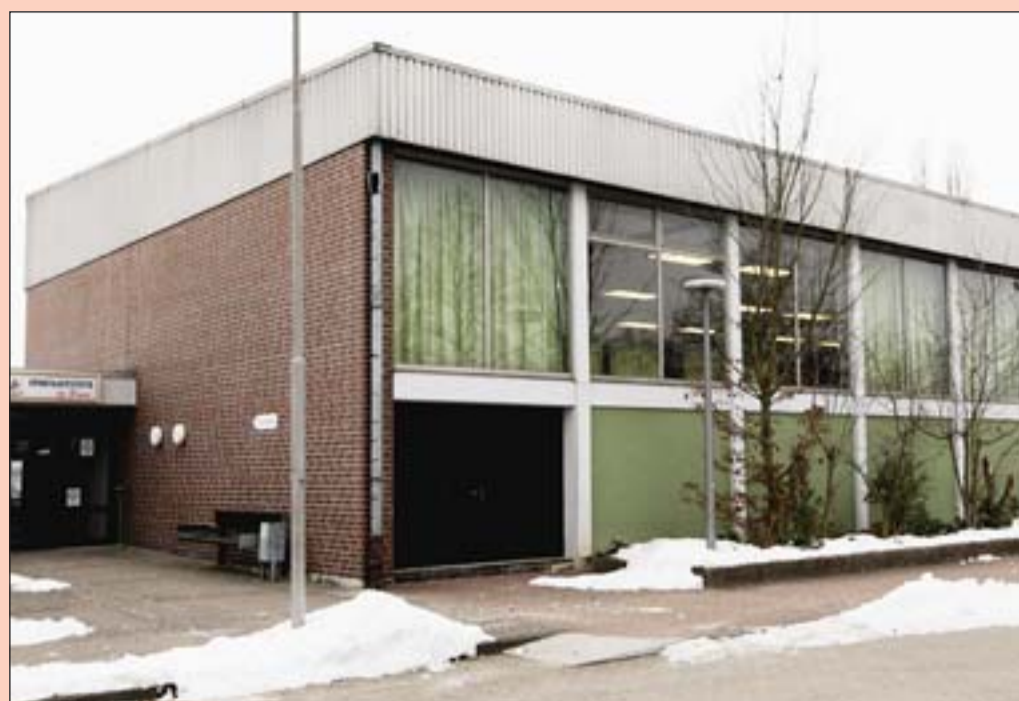
Turnhalle Heiligendorf: Die PUG beantragte eine Dachsanierung.
